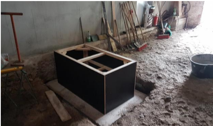
Fast fertig: das Fundament für einen Lufthammer
