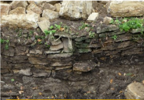
Die alte Bruchsteinmauer ist freigelegt
