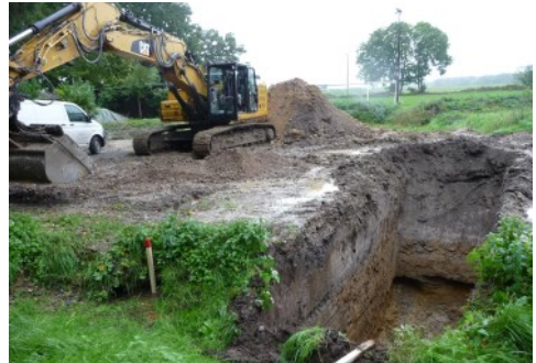
Die Grube für die Zisterne wird ausgehoben
