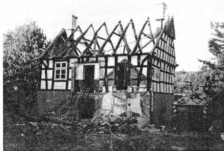
Abb. 5 Der Speicher in der Renovierungsphase 1985/86. Rechts Hof Löhr
