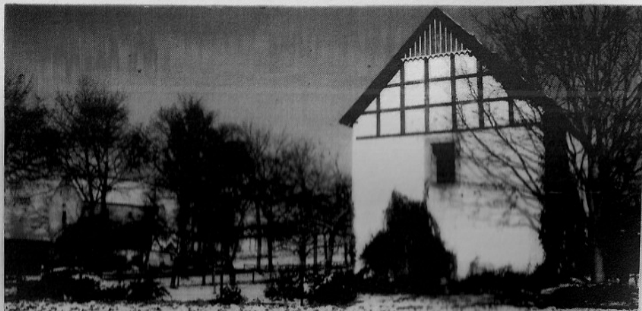
STEINWERK & SPEICHER, ELLERBECK
