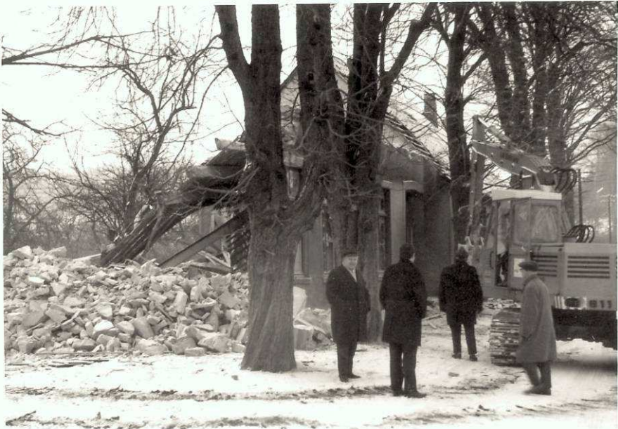
Abriss der Schule 1965. Fiel da auch die Pissbude dem Bagger zum Opfer? Links: Bgm F. Depenthal, Mitte: GD Pohlmann, Rechts: Lehrer Haubold
