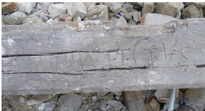
Abb.: Das Wort PRAEFFECTUS ist hier deutlich zu erkennen. Das Foto wurde gleich nach der Demontage des unbehandelten Balkens aufgenommen.
