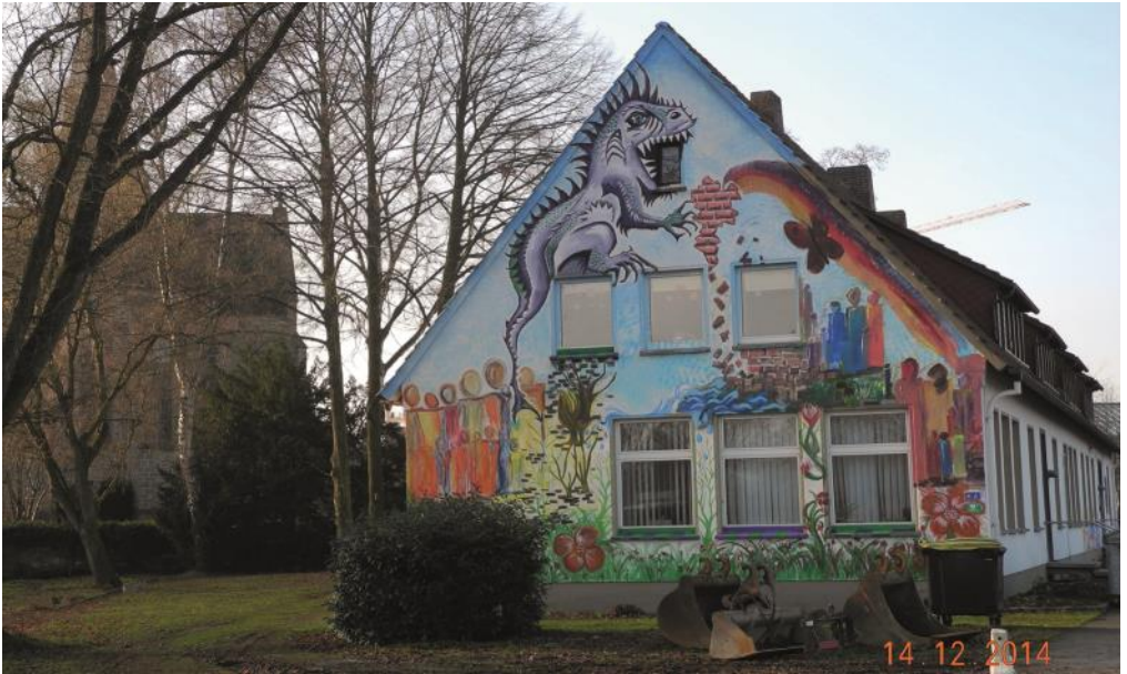
A.: Der bemalte Ostgiebel des Rathauses vor dem Abbruch
