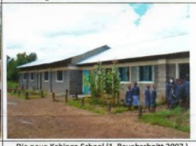
Die neue Kahingo School (1. Bauabschnitt 2007)
