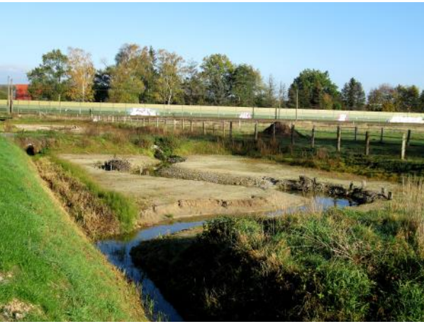
Die neuen Mäander des Johannesbaches hinter der Bahn
